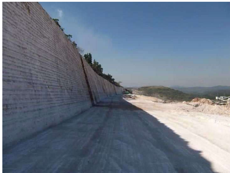
仕上がり状況
