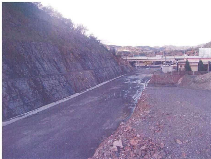
仕上がり状況
