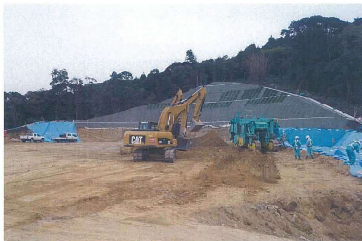
掘削状況 2500SM
