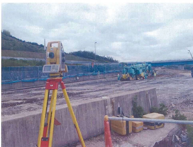
情報化施工 状況
