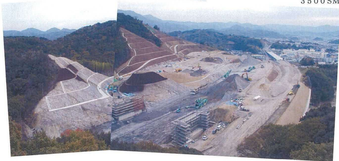
掘削状況 3500SM
