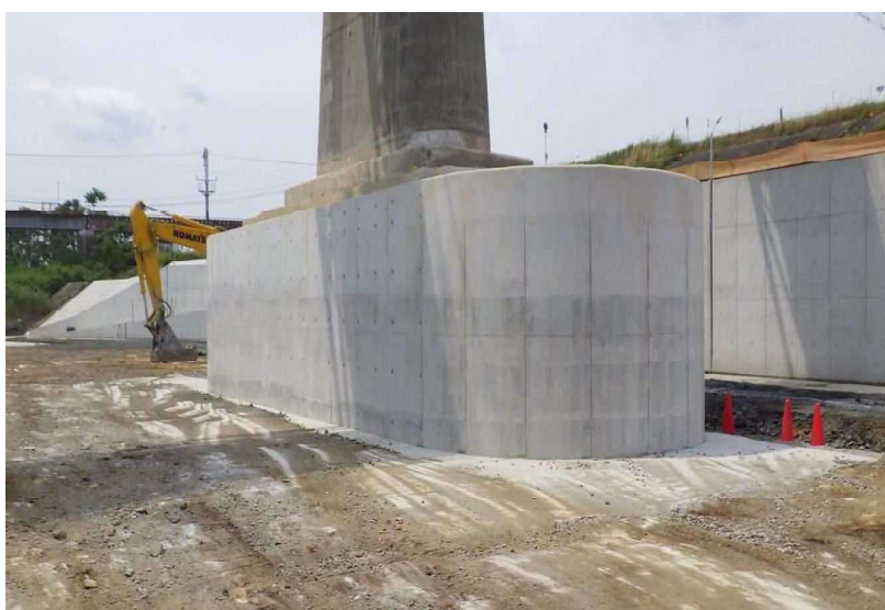
仕上がり状況
