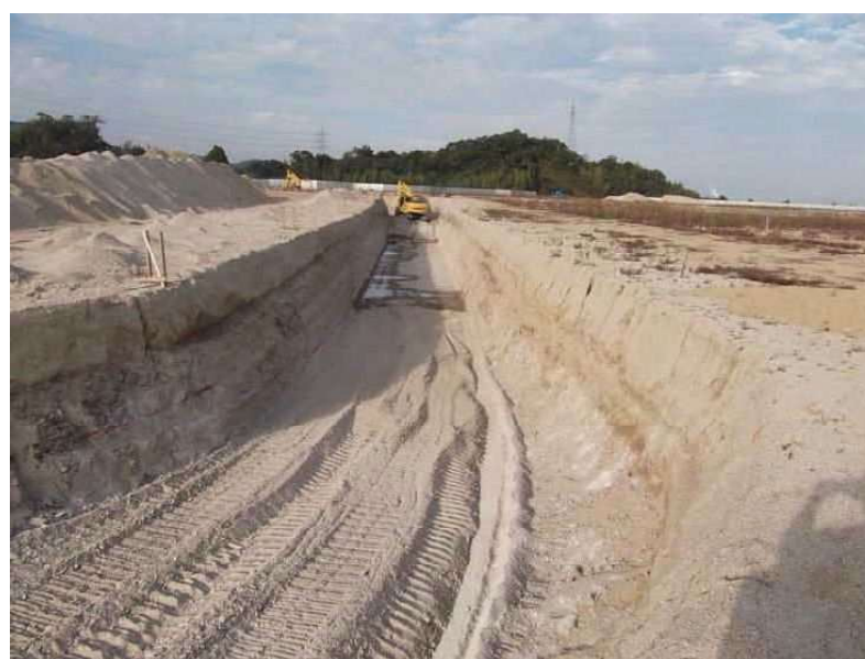
仕上がり状況
