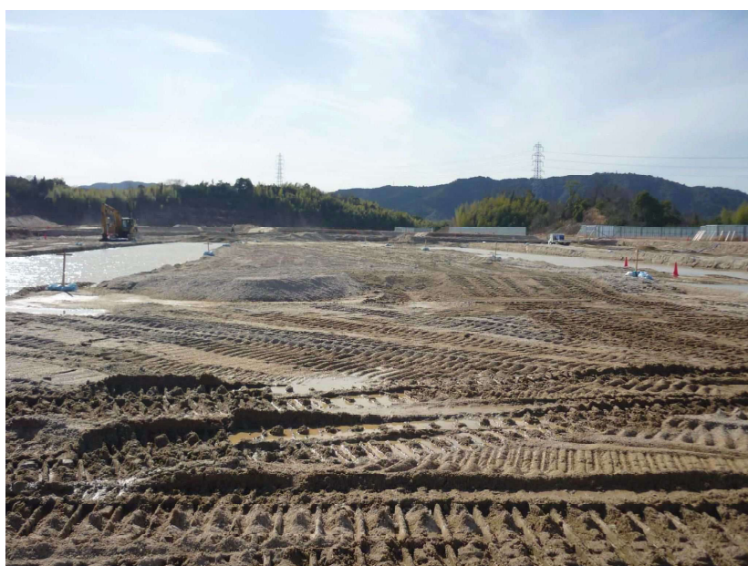
仕上がり状況
