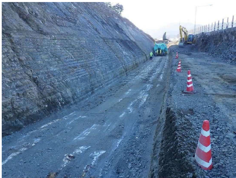
仕上がり状況
