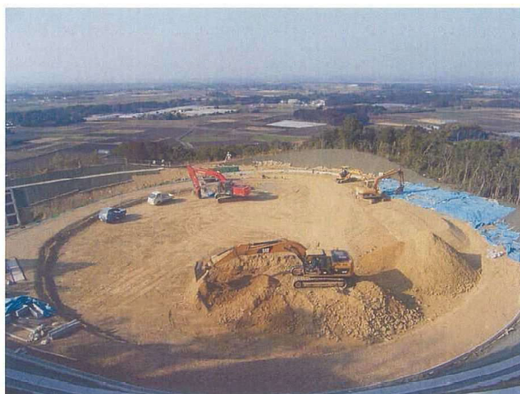
仕上がり状況
