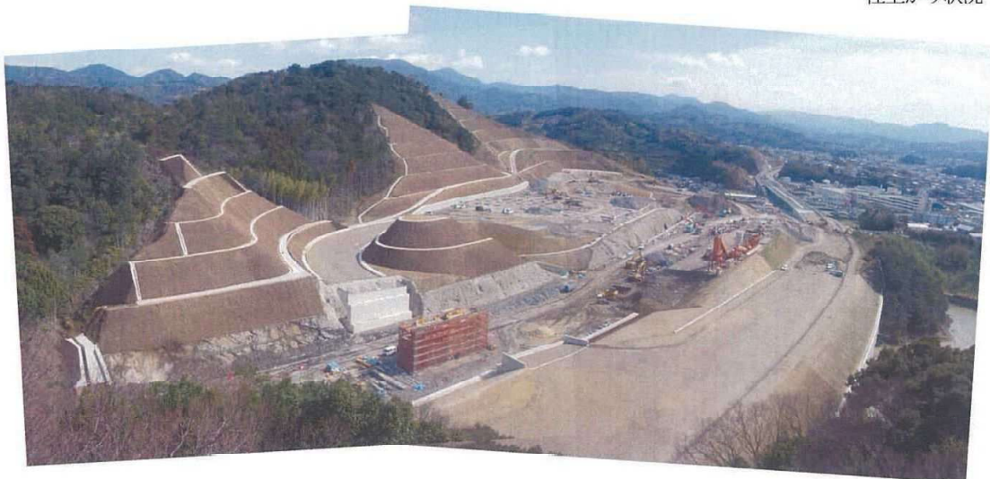
仕上がり状況
