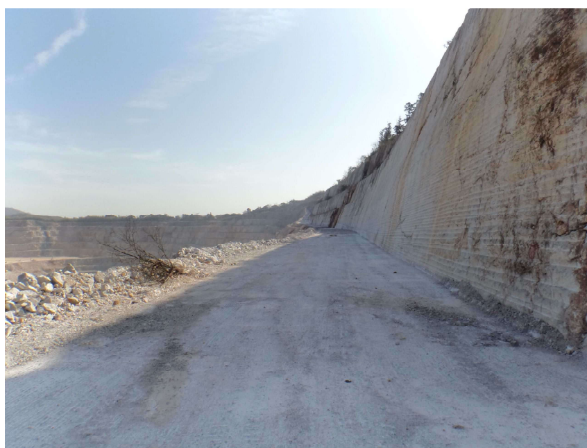
仕上がり状況
