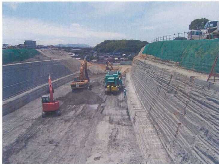
掘削状況 2500SM
