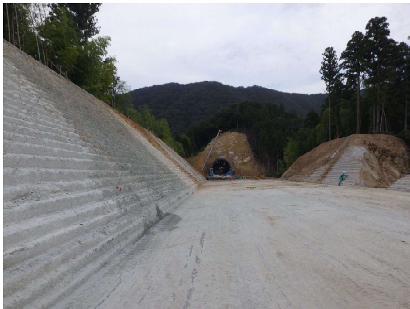
仕上がり状況
