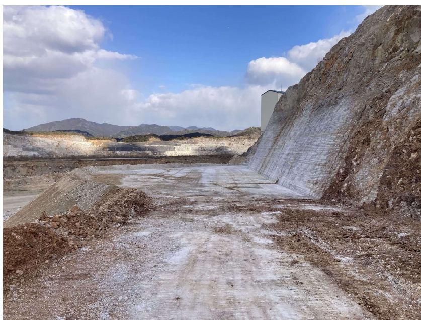
仕上がり状況
