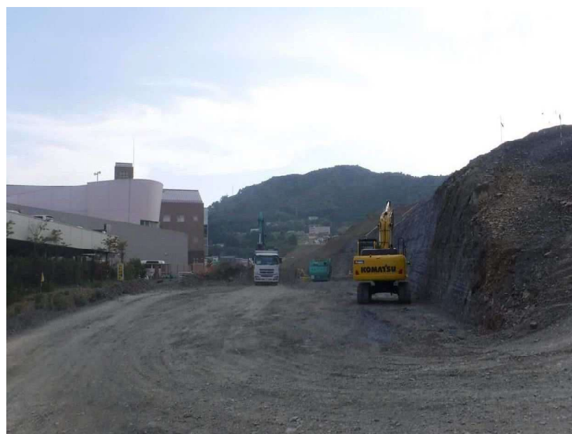
仕上がり状況
