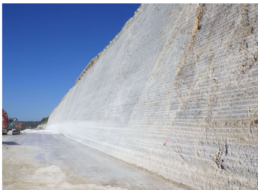
仕上がり状況
