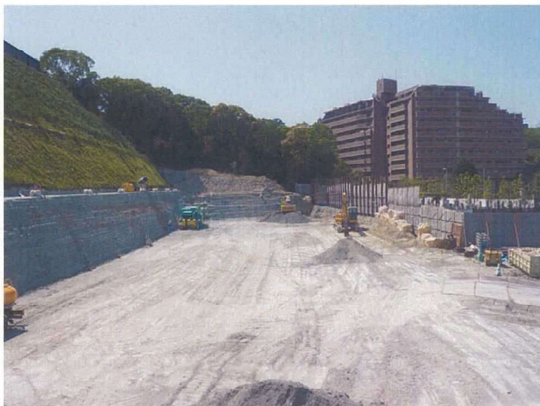
仕上がり状況
