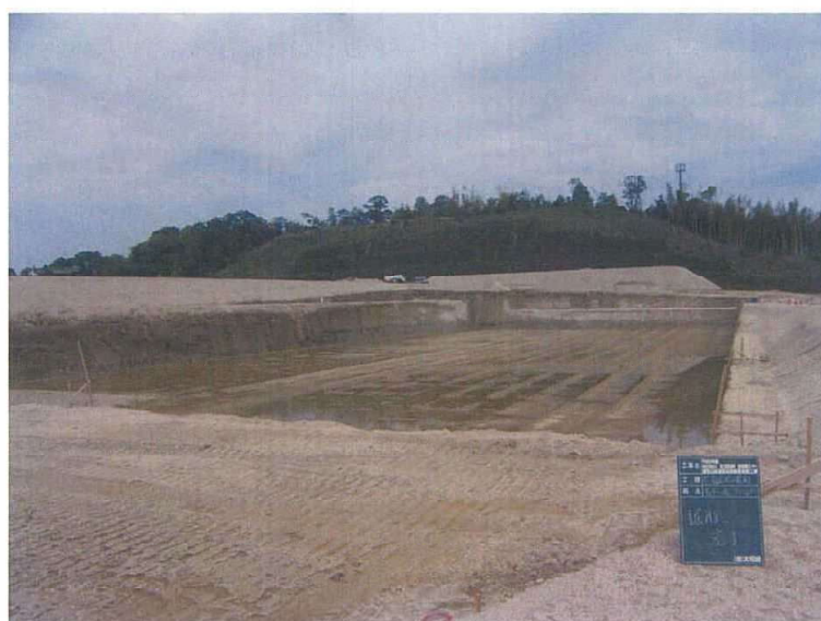
仕上がり状況
