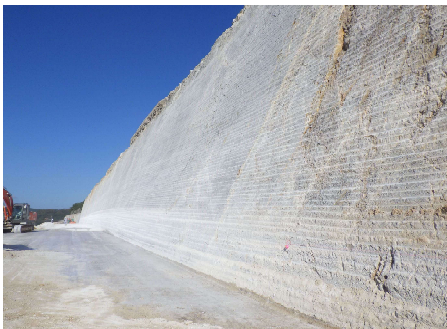
仕上がり状況
