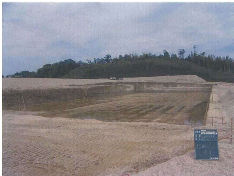
仕上がり状況
