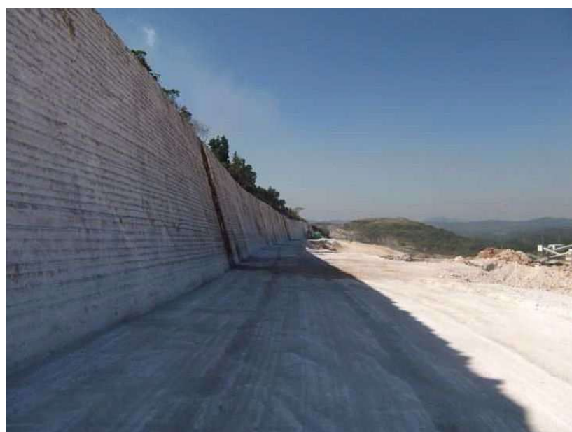
仕上がり状況
