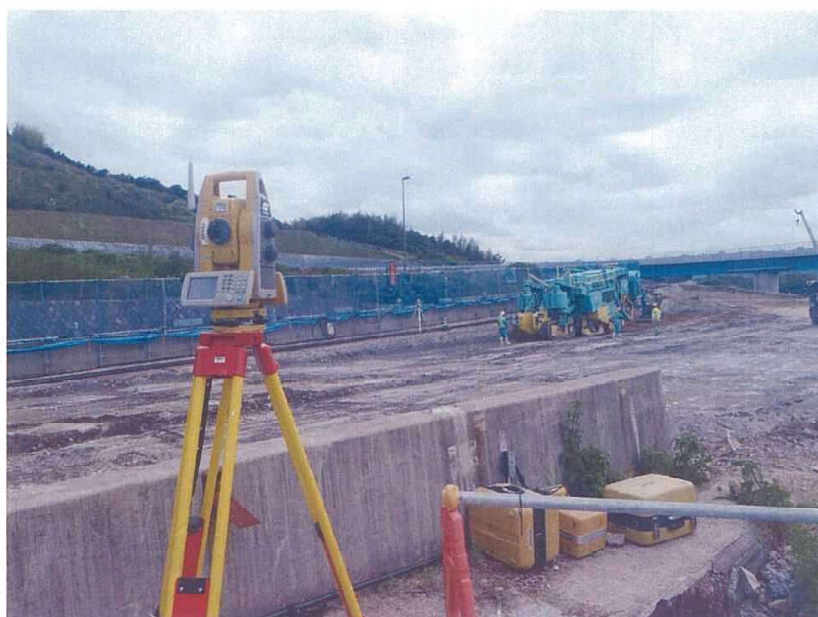
情報化施工 状況
