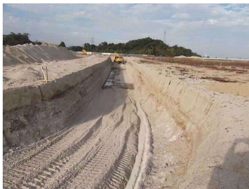
仕上がり状況
