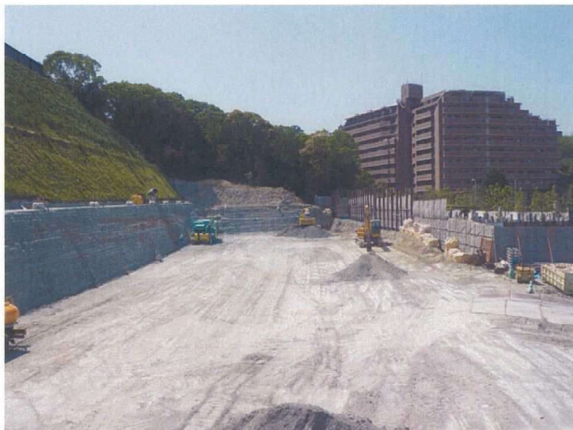
仕上がり状況
