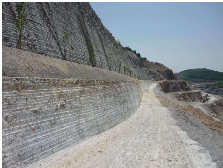
仕上がり状況
