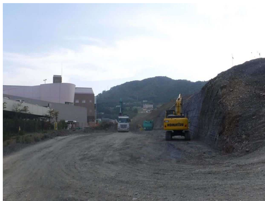
仕上がり状況
