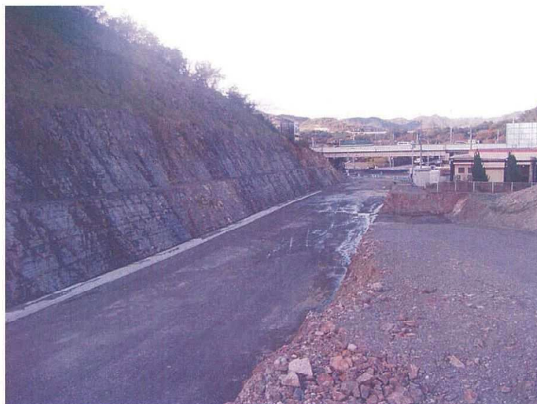
仕上がり状況
