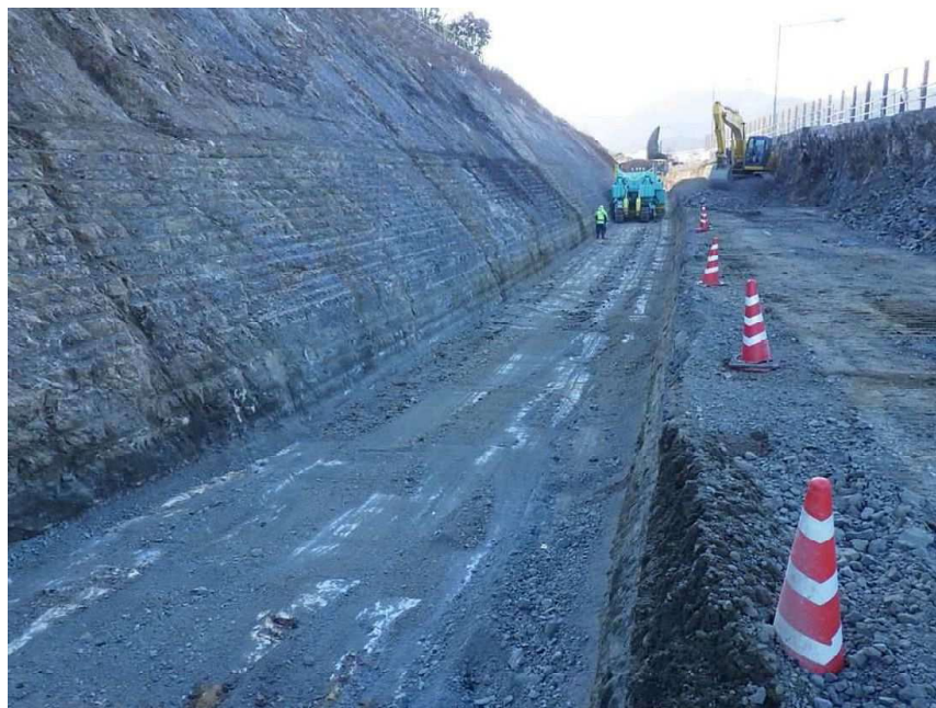
仕上がり状況
