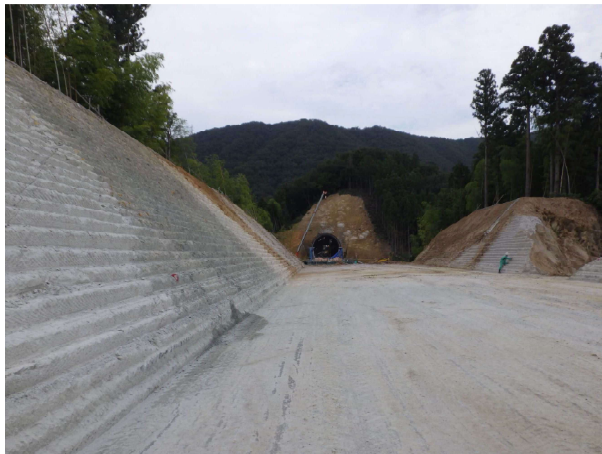
仕上がり状況
