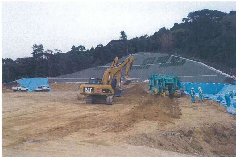
掘削状況 2500SM
