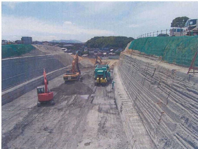
掘削状況 2500SM
