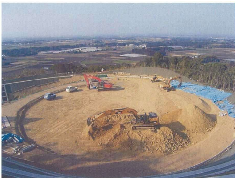
仕上がり状況
