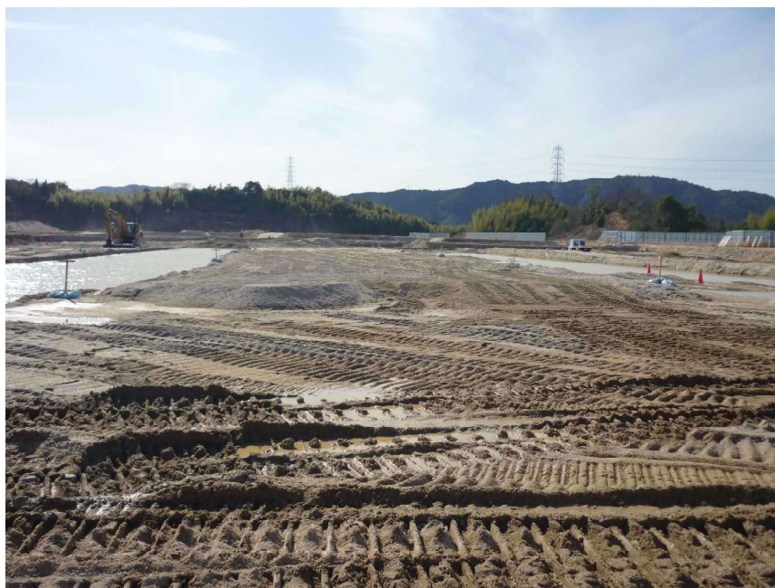
仕上がり状況
