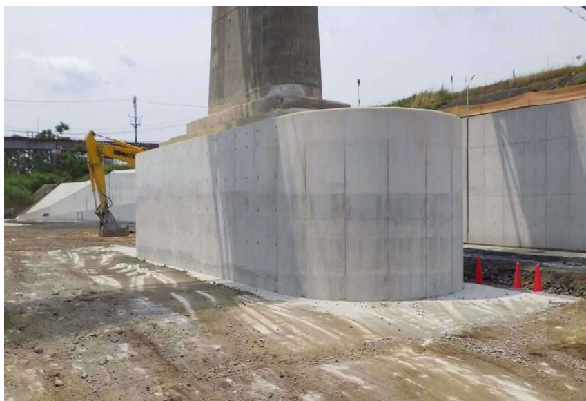
仕上がり状況
