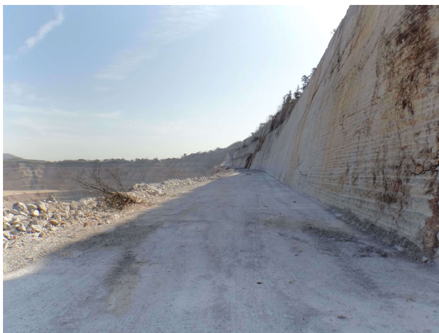
仕上がり状況
