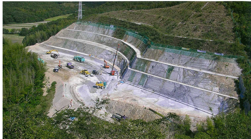
整備局: 姫路北 BP 石倉地区改良工事
