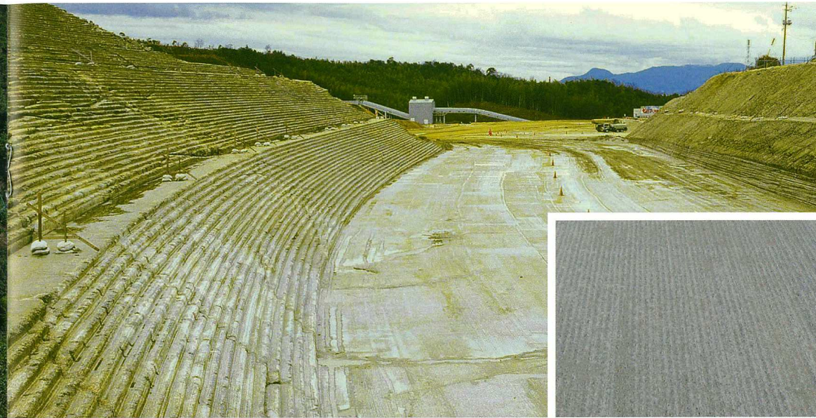
山口県住宅供給公社 愛宕山地域開発事業造成工事
