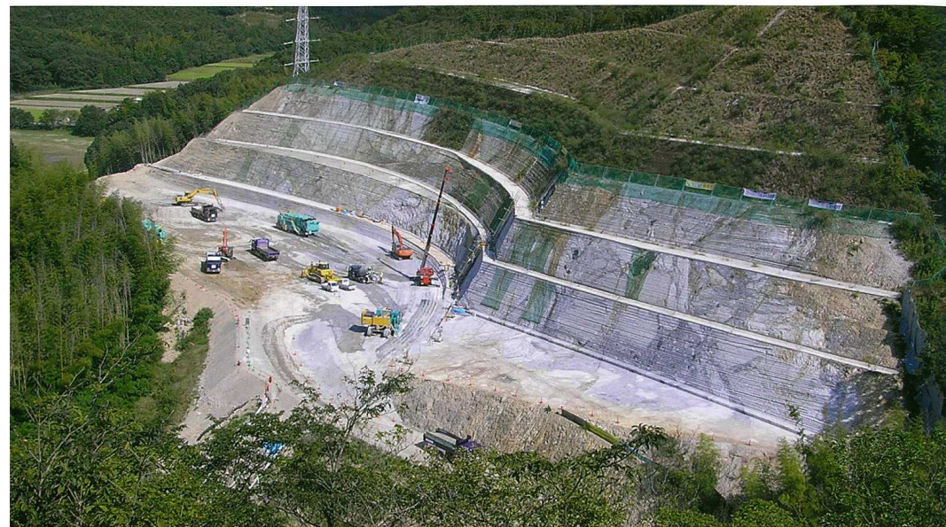
与整備局: 姫路北 BP 石倉地区改良工事
