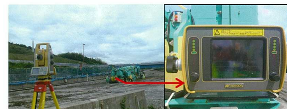
情報化施工(マシンコントロール)による高精度な基面仕上げ
