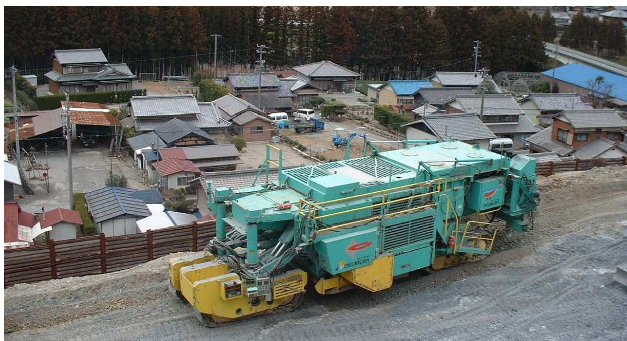
住宅密集地の近接部での施工
