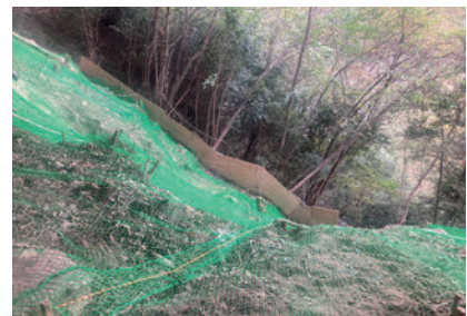
令和6年7月 浜田自動車道本郷地区のり面応急復旧工事
