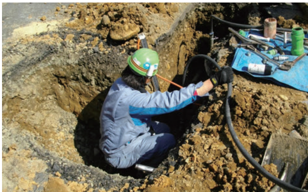
東日本大震災 ガス復旧工事
