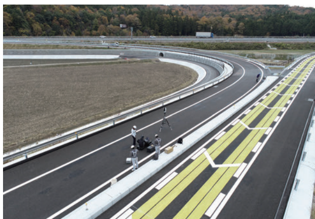
多賀SIC(上り線)工事
