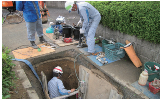
熊本地震 ガス復旧工事
