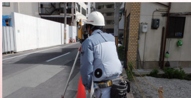
空調服を着用して作業している様子
