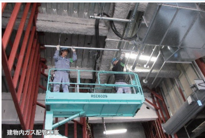
ガス管入替工事(非開削)
