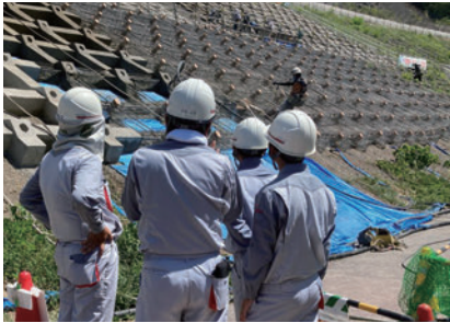
岡山工業高等学校の現場見学会 和歌山高速道路事務所管内（特定更新等） 盛土補強工事
