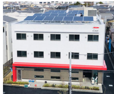
塚口宝来寮 太陽電池パネル設置状況
