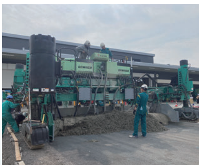
施工状況 (スリップフォーム工法)
