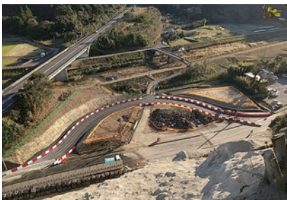
令和4年12月 高速道路のり面崩落事象応急復旧工事
