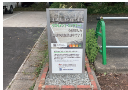
施工現場：PR看板設置
