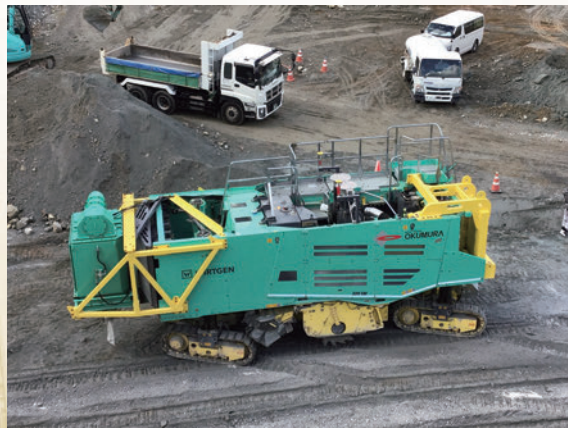
3D-MCによる切削状況(移動局)
