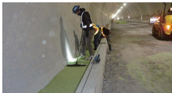
「一般国道168号阪本トンネル工事」における納入状況
