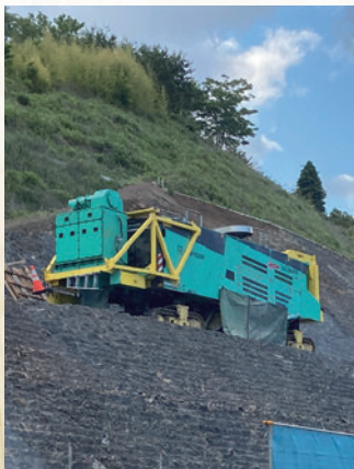
岩盤切削機施工状況
