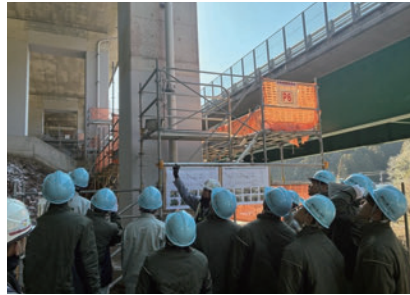
高知工業高等学校の現場見学会 高知自動車道 井床橋他4橋耐震補強工事
