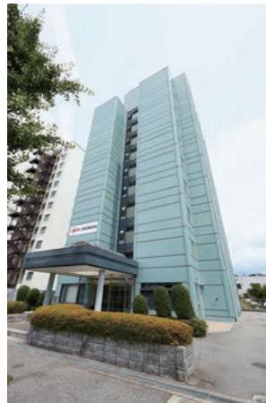
社員寮「ハーバーゴールド寮」 (大阪市港区)
