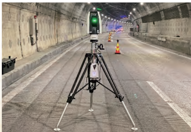
レーザートラッカーによる3次元測量
