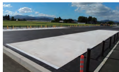
施工現場：道の駅はなまき西南
