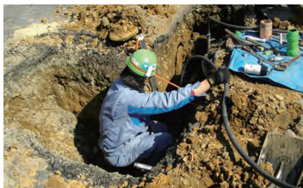
東日本大震災 ガス復旧工事
