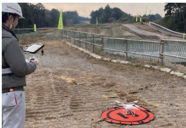
UAVを用いた3次元測量
