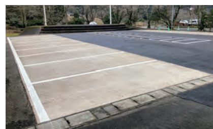
施工現場：道の駅美山ふれあい広場
