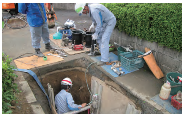
熊本地震 ガス復旧工事
