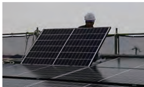
太陽光発電パネル設置施工状況
