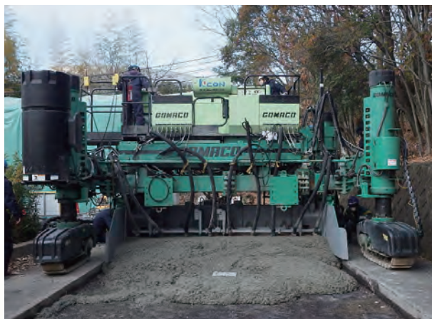
試験施工状況（近畿技術事務所内）
