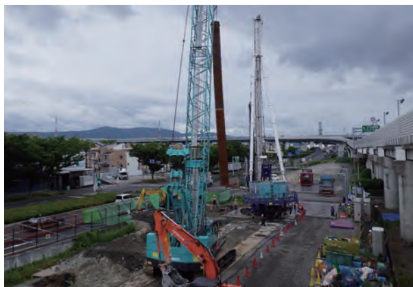
施工状況(既製杭工)
