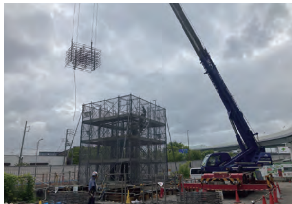
施工状況(鉄筋組立)
