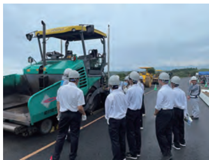
松江工業高等専門学校の現場見学会 R5 湖陵・多伎道路久村地区第2 舗装工事
