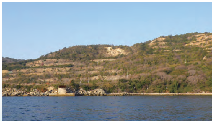
家島採石場跡地の緑化のり面
