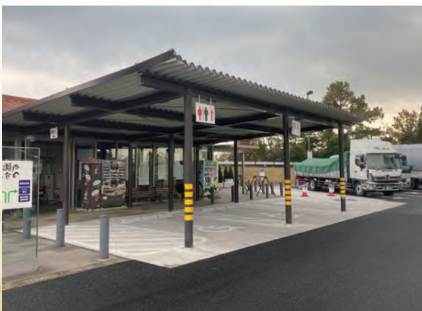
施工現場：道の駅瀬戸しなの
