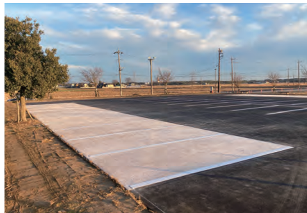
施工現場：道の駅思川
