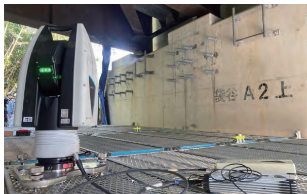
レーザートラッカーによる3次元測量
