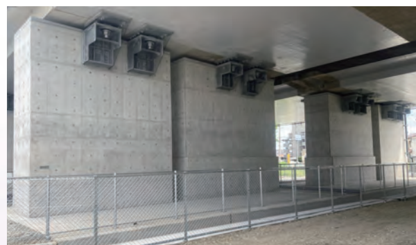
水平力分担構造の取付完了
