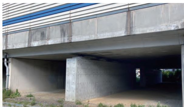
新設橋脚の施工完了
