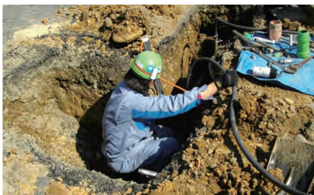
東日本大震災 ガス復旧工事
