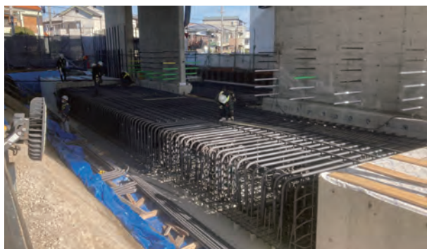
橋脚フーチングの鉄筋組立完了
