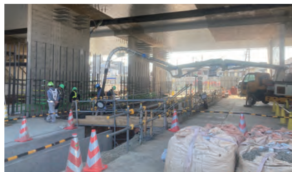
橋脚フーチングのコンクリート打設
