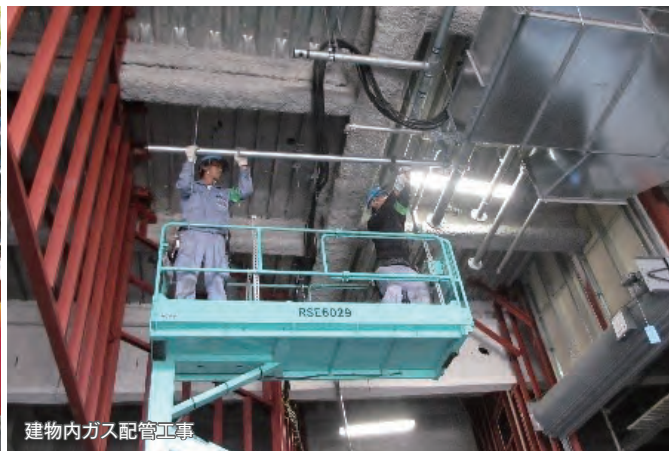
ガス管入替工事（非開削）
