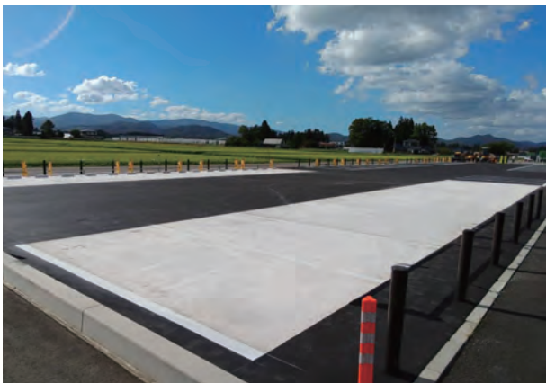
施工現場：道の駅はなまき西南
