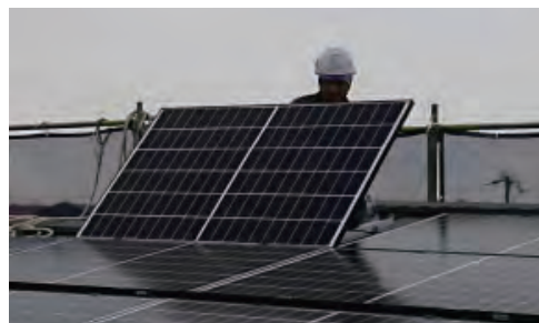
太陽光発電パネル設置施工状況
