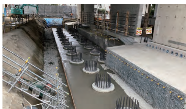
場所打ち杭の施工完了
