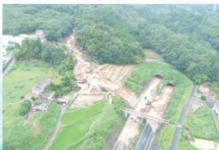
平成30年7月豪雨災害 写真は西日本高速道路(株)様より提供
