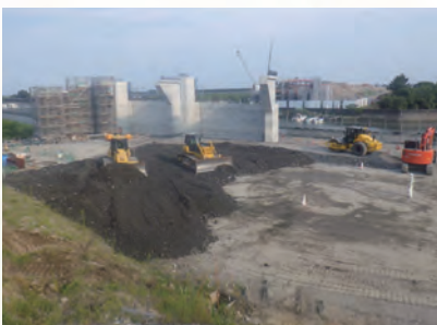
施工状況（土工）
