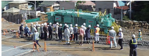
化粧坂道路改良(その3)工事
