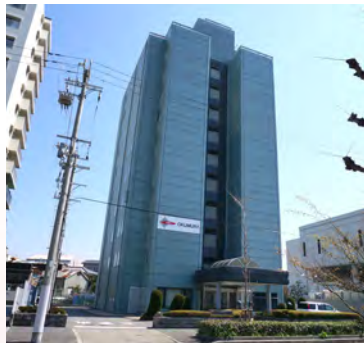
社員寮「ハーバーゴールド寮」(大阪市港区)
