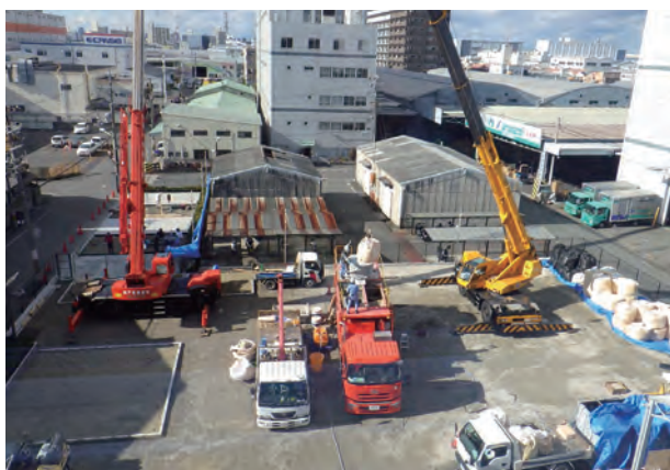
試験施工全景
