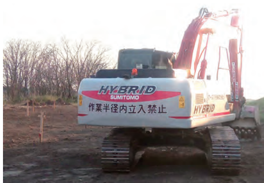
ハイブリッドバックホウ導入 【R1 鬼怒川右岸中築堤工事】
