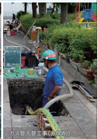
ガス管入替工事(非開削)
