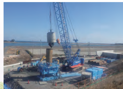
施工状況（場所打ち杭）
