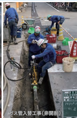
ガス管入替工事(非開削)
