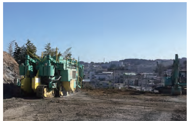
化粧板道路改良（その3）工事で施工中の2500SM
