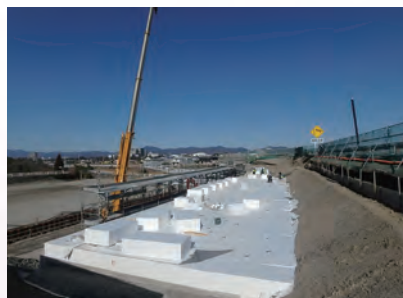
施工状況（軽量盛土）
