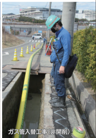
ガス管入替工事(非開削)
