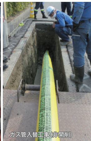
ガス管入替工事(非開削)
