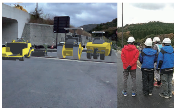
MRを利用した建設機械の配置シミュレーション状況
